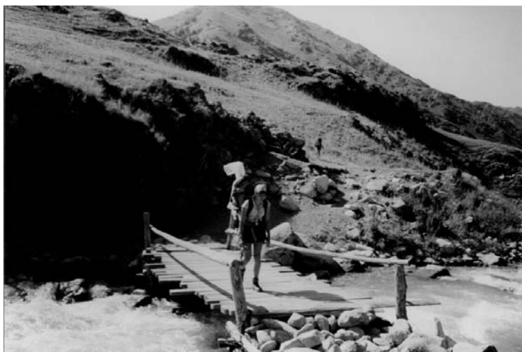
15. мост через р. Малая Чижя
